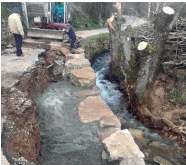
Los destrozos por la riada fueron cuantiosos
