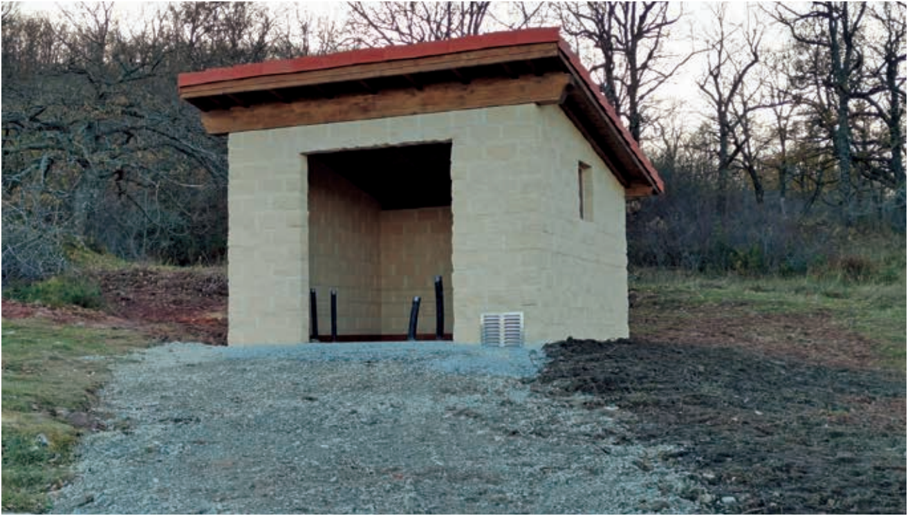
Obra de potabilización de agua en la caseta del equipo de filtración en Celada
