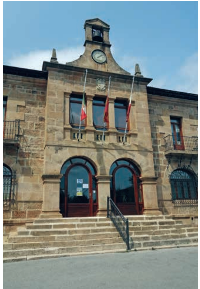
Fachada del Ayuntamiento de la Hermandad de Campoo de Suso
