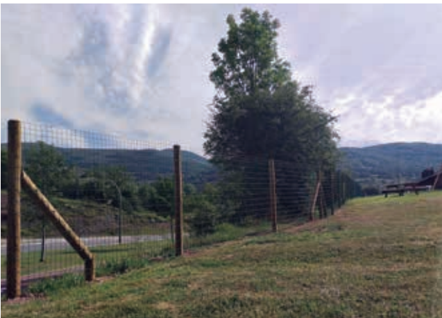
Luce el nuevo vallado del recinto
